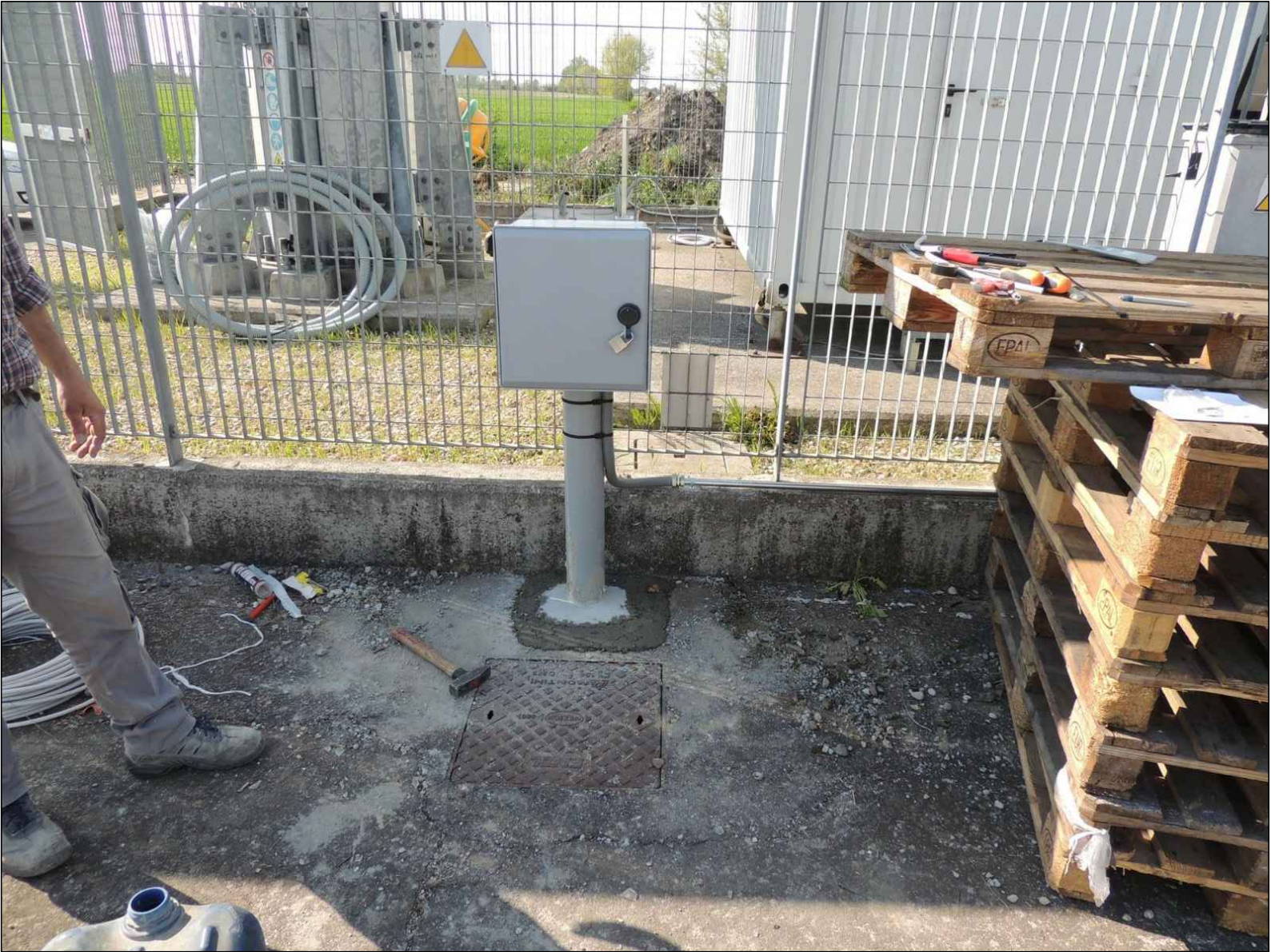
ESEMPIO PER ALLOGGIO CONTATORE ENEL + QPL (PREVEDERE KIT CASSETTA + PALINA)
